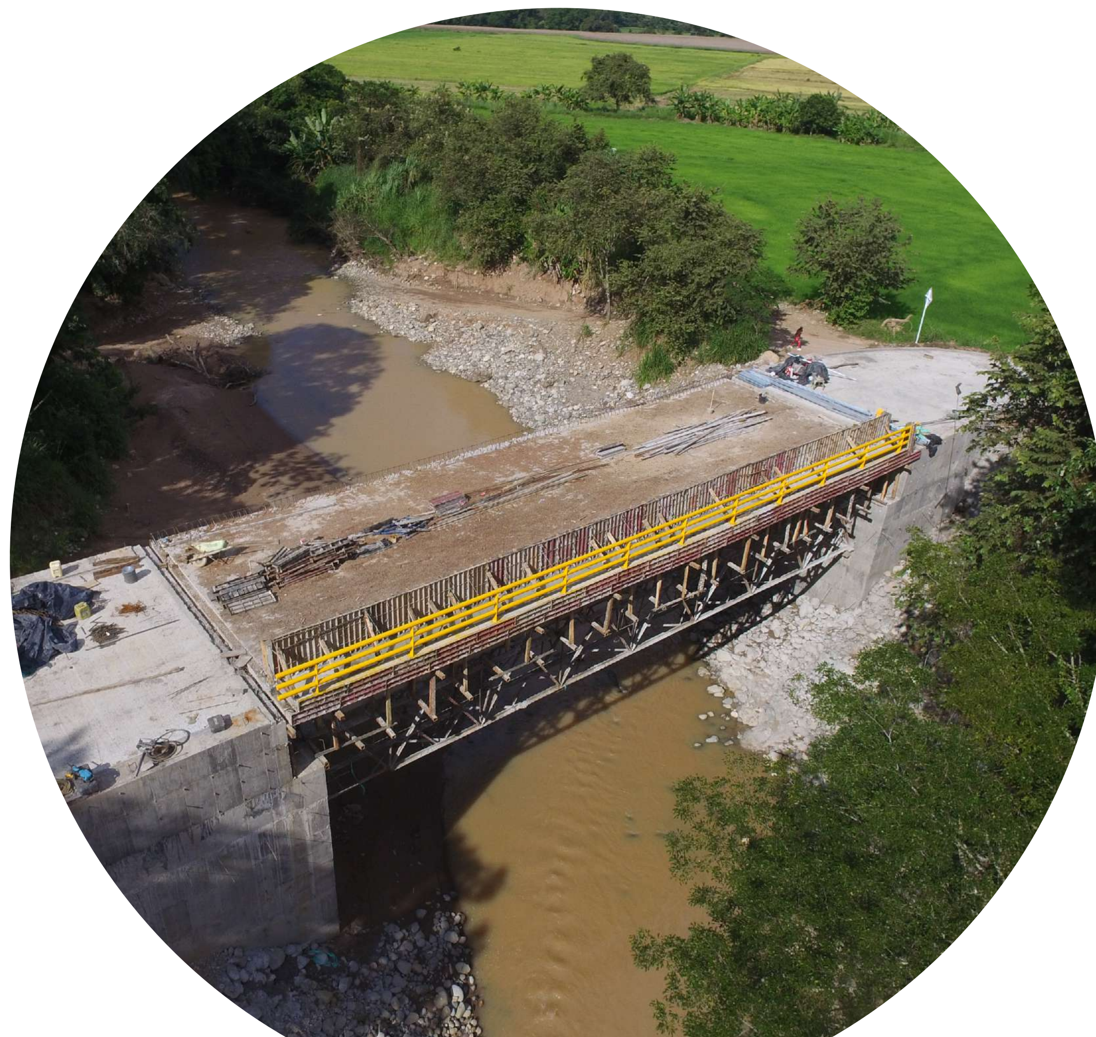
Construcción del puente sobre la quebrada El Neme. Corregimiento Amoyá. Chaparral Tolima. Proyecto Obras por impuestos
