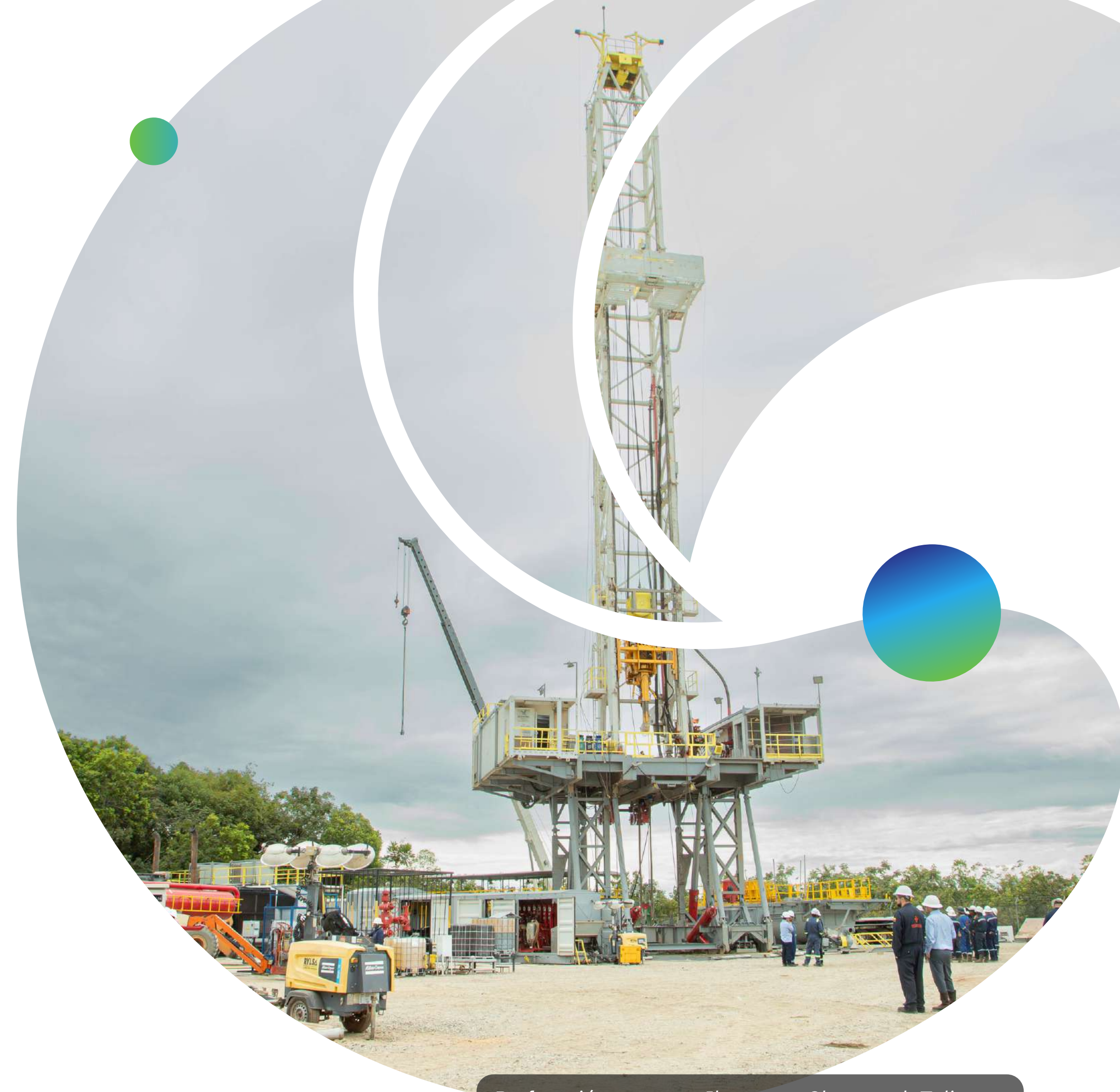
Perforación proyecto Ibamaca. Chaparral. Tolima.
